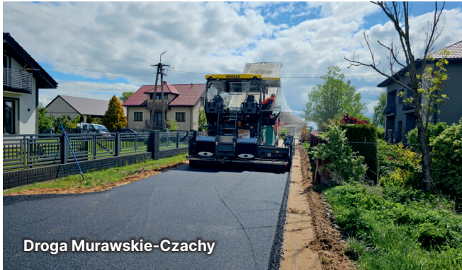
Odbudowa drogi z wykorzystaniem destruktu asfaltowego
