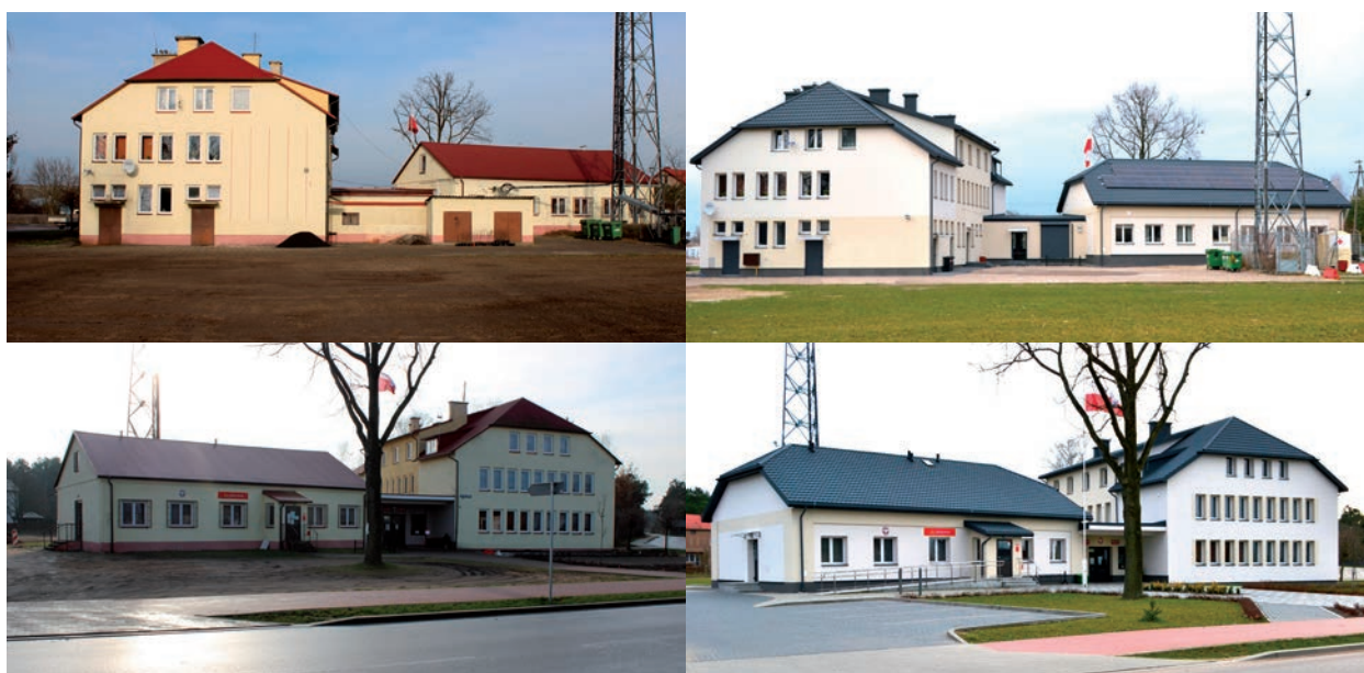
Urząd gminy przed i po remoncie
