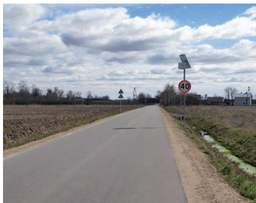
Wyremontowana droga Drewnowo-Gołyń- Białe Szczepanowice
