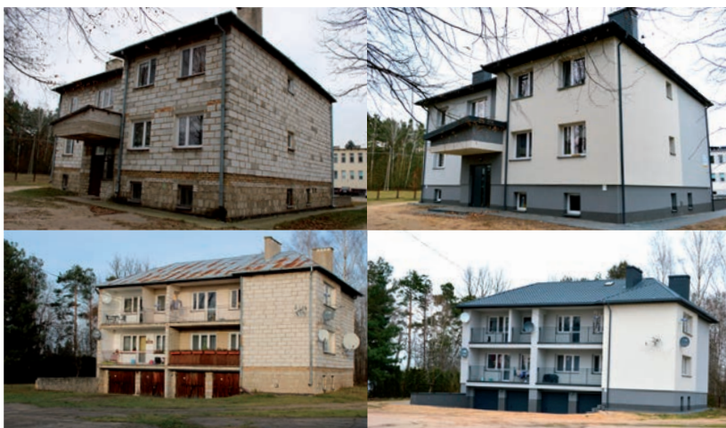
Dom lekarza przed i po remoncie
