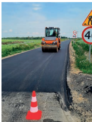
Budowa drogi Drewnowo-Gołyń
