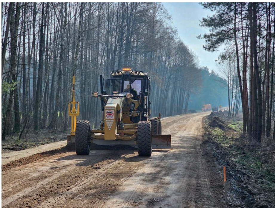
Budowa drogi gminnej Boguty-Pianki – Tymianki-Bucie
