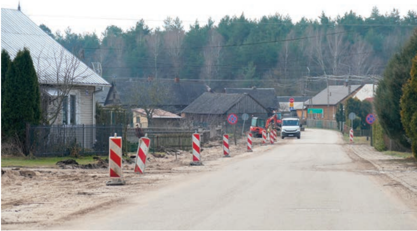
Budowa chodnika na ulicy Kościelnej
