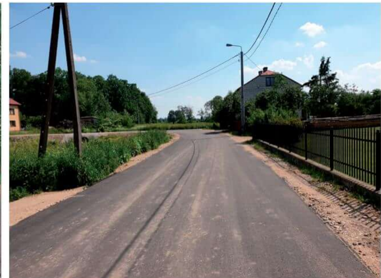
Remont drogi z użyciem destruktu asfaltowego.
